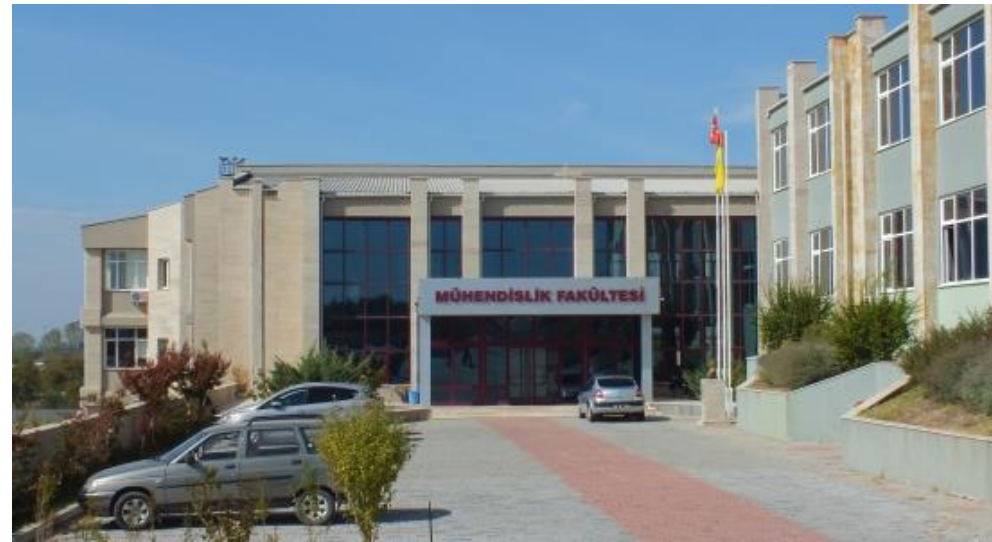
Trakya Üniversitesi Mühendislik Fakültesi Binası 3 000 m 2
