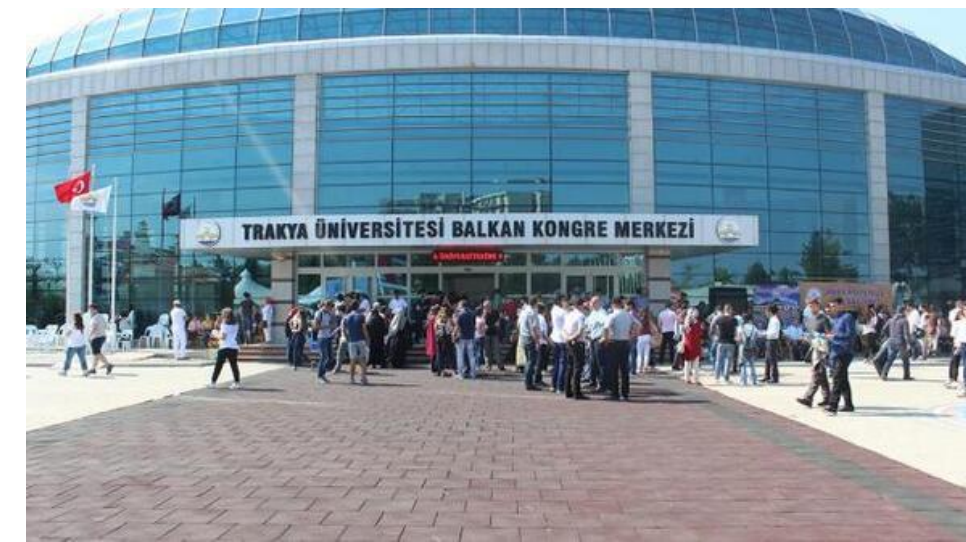
Trakya Üniversitesi Öğrenci İşleri Merkezi Binası 3 000 m 2
